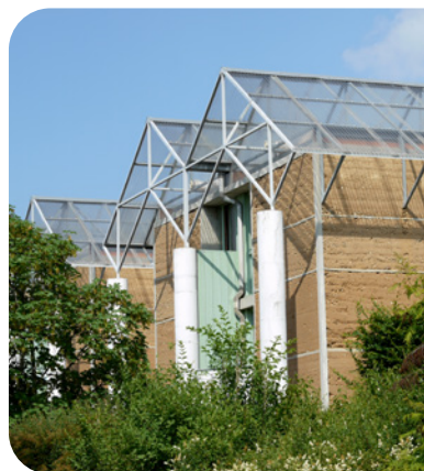
© CRAterre, T. Joffroy - Mur en terre
