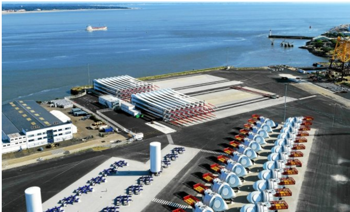
La base d'assemblage des composants d'éoliennes du parc en mer de Saint-Nazaire. Un espace de 12 ha sur le port de Nantes Saint-Nazaire (© Port Nantes Saint-Nazaire/Franck Badaire)
