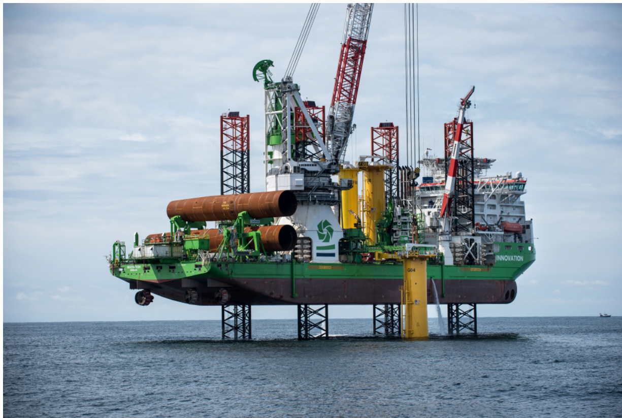
Installation des fondations du parc éolien en mer de Saint-Nazaire (© Parc éolien en mer de Saint-Nazaire/Production CAPA Corporate)
