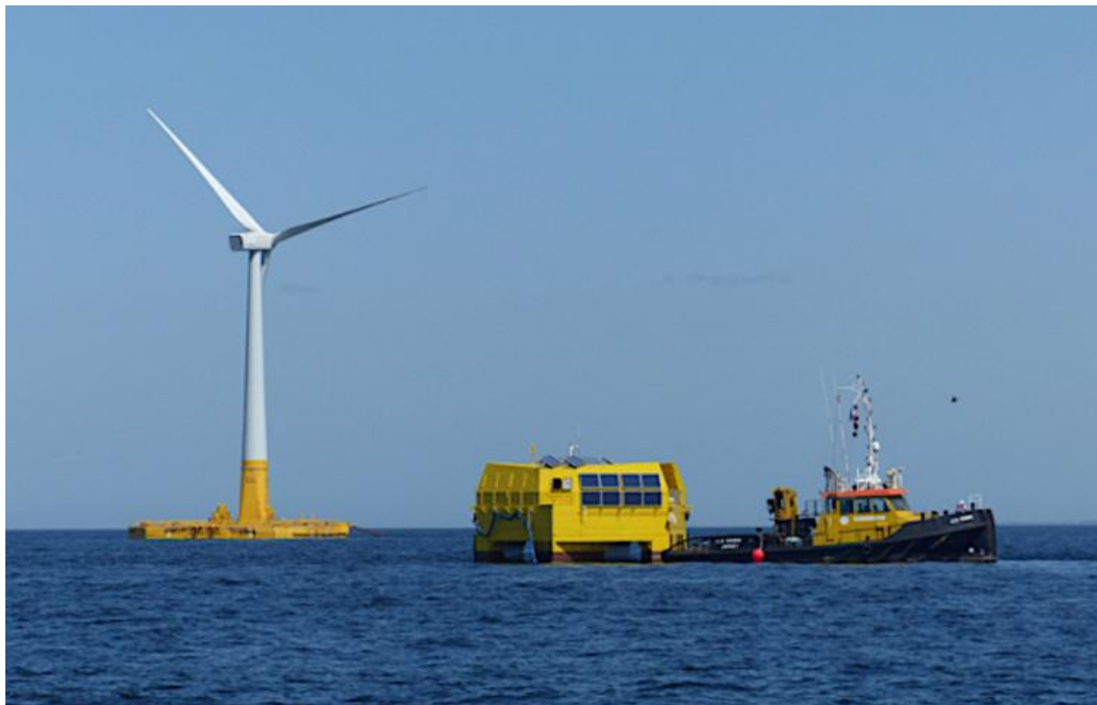
SEM REV, 1 er site européen d'essais en mer multi-technologies connecté au réseau (© Centrale Nantes)
